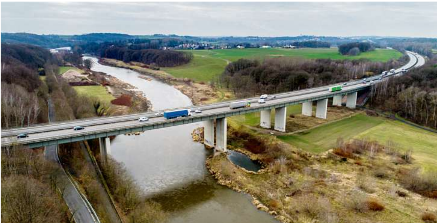
Vor 50 Jahren ist die Autobahnbrücke, die bei Grimma das Muldetal überspannt, errichtet worden. Durch den stetig zunehmenden Verkehr ist die Standfestigkeit nur noch für eine begrenzte Zeit gewährleistet. Deshalb wird ein Neubau notwendig. Foto: Dietmar Thomas
