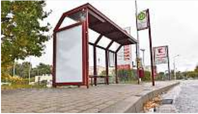
Der Bushalt an der Wilsdruffer Straße wird, wie acht weitere Haltestellen, barrierefrei ausgebaut. Foto: Egbert Kamprath
