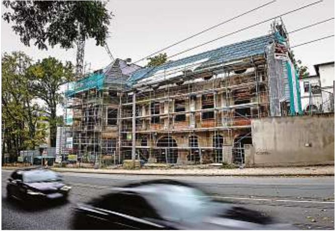
Bis zum Winter erhält das Gebäude ein neues Dach. In seinem Spitzboden befindet sich das Sommerquartier für zahlreiche Fledermäuse. Die Fassade wird grün.
