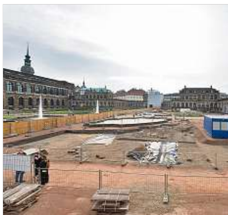
Um 1800 gab es vier große Teiche im Zwingerhof. Am linken Bildrand ist die freigelegte Kante eines Teiches sichtbar.
