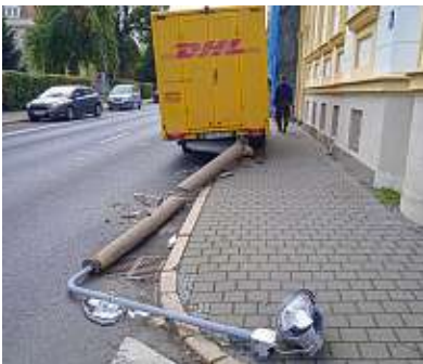
Die Laterne war so stark beschädigt, dass schließlich die Stadtwerke anrücken mussten.
