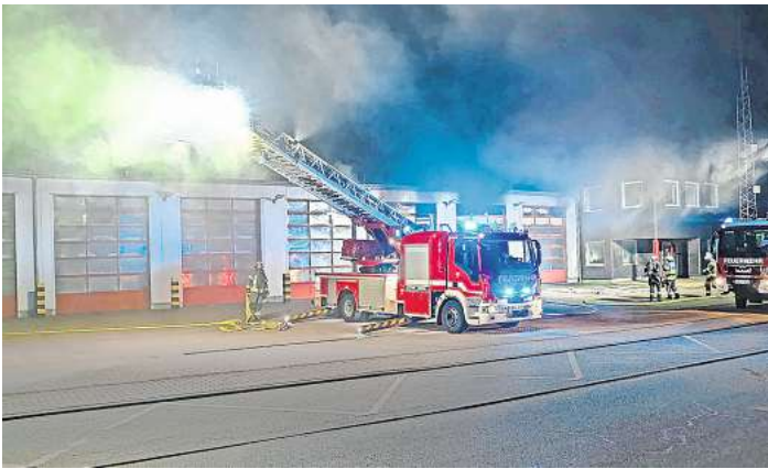
Am Morgen des 14. September brannte die Fahrzeughalle der Feuerwehr Oldenburg komplett aus.
