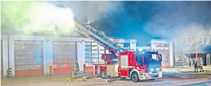
Am Morgen des 14. September brannte die Fahrzeughalle der Feuerwehr Oldenburg komplett aus.
