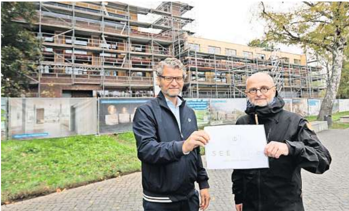
Reinhard Sohns (r.) und Bauleiter Stephan Barnstedt vor dem Rohbau des Inklusionshotel an der Eutiner Stadtbucht FOTO: ULRIKE BENTHIEN
