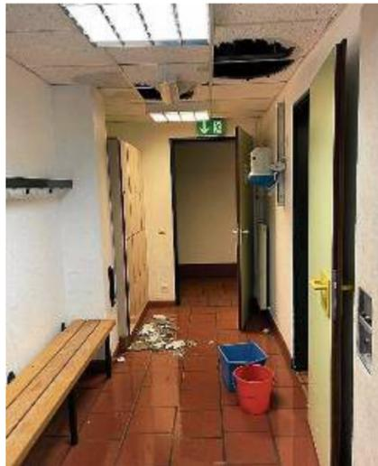
Wasser tropft durch die Decke in den Flur, der zu den Umkleieräumen führt. Platten sind zu Boden gestürzt.
