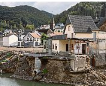
Der Wiederaufbau in den Flutge-bieten, wie hier im Ahrtal, wird viel Geld kosten.
