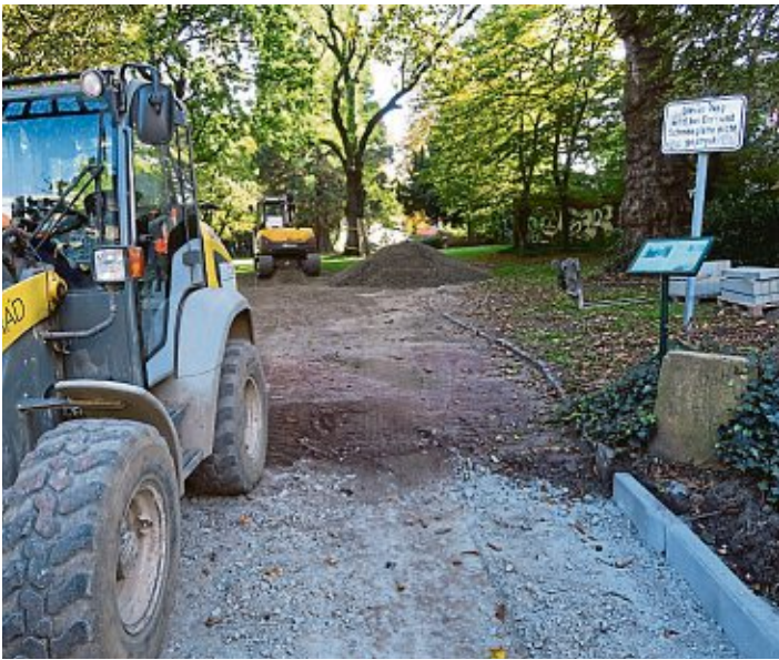
Die Bagger rollen am Stadtgarten an.
