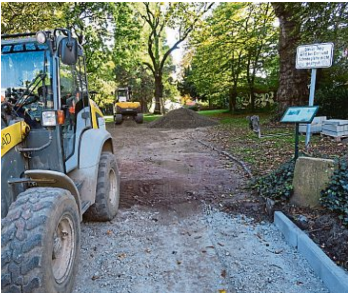
Die Bagger rollen am Stadtgarten an.
