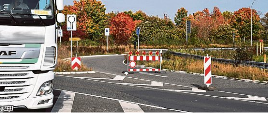
Gesperrt ist die Rechtsabbiegespur am Bauhauskreisel. Das soll vor allem den Schwerlastverkehr aus Efferen heraushalten. Foto: Engels
