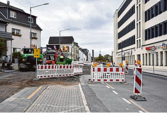
Die Kölner Straße erhält in Höhe des Einkaufszentrums Intro am Samstag, 23. Oktober, eine neue Fahrbahndecke. Foto: Fratz
