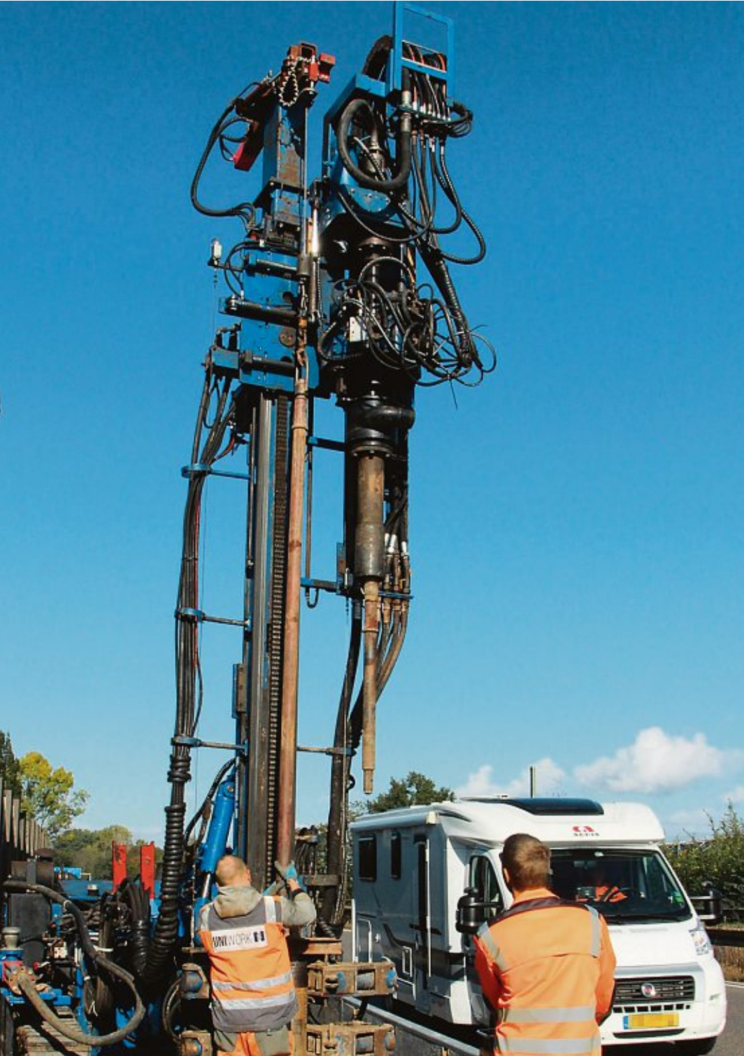
Während die Autos vorbeirasten, schraubte das Bohrteam seelenruhig Stange auf Stange aufeinander, bis eine Bohrtiefe von 30 Metern erreicht war. Fotos: Villinger
