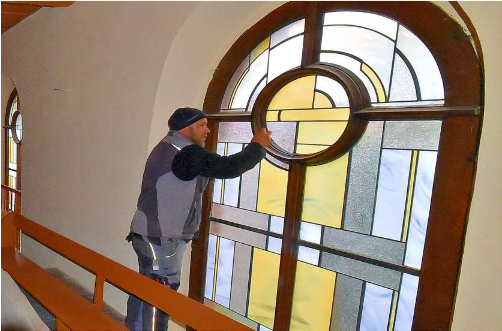
In der Kirche Radegast wurden vier weitere Fenster des Künstlers Thomas Kuzio eingebaut. Glaser Philipp Schulz vom Glasstudio Derix aus Taunusstein nimmt die letzten Handgriffe an den Fenstern vor. Radegasts Backsteinkirche kann nun insgesamt 15 Fenster von Thomas Kuzio vorweisen. FOTO: UTE NICKLISCH
