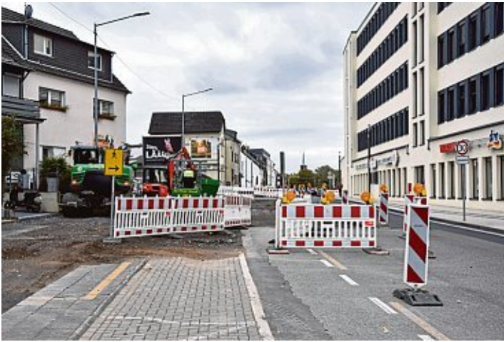
Die Kölner Straße erhält in Höhe des Einkaufszentrums Intro am kommenden Samstag eine neue Fahrbahndecke. Foto: Fratz
