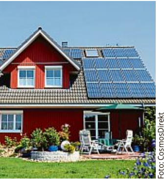
Photovoltaik auf Privathaus
