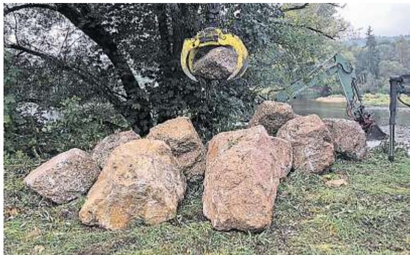
Am Wehr in Ramspau ist der Bagger im Einsatz, um Störsteine ins Wasser zu setzen. Sie sollen künftig helfen, Laichplätze für selten gewordene Fischarten zu schaffen.
