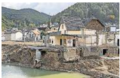
Die versicherten Schäden der Hochwasserkatastrophe im Sommer sind hoch. FOTO: B. ROESSLER/DPA
