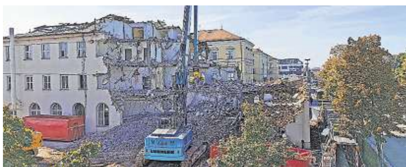
Das Haus in der Bahnhofstraße 20 wird abgerissen.
