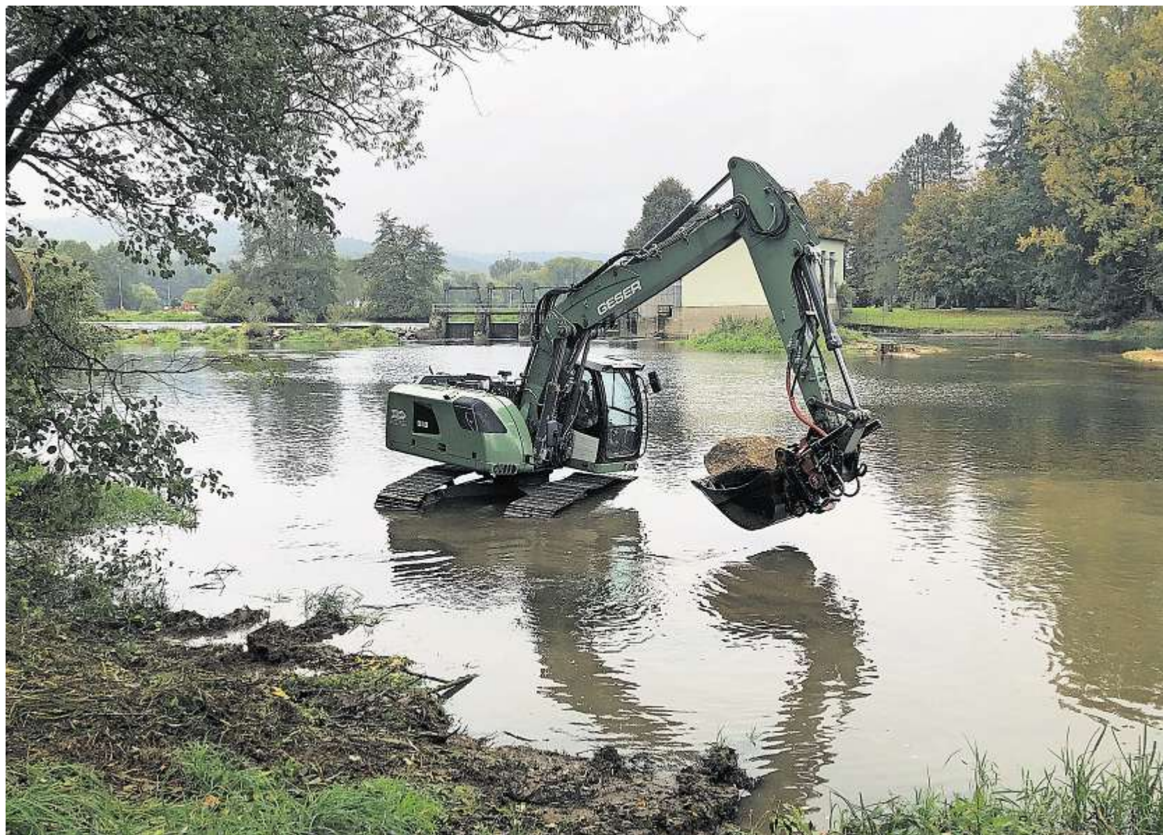
Unterhalb des Ramspauer Wehrs war ein Bagger im Einsatz. Das Besondere: Die Maschine arbeitete direkt im Fluss Regen.
