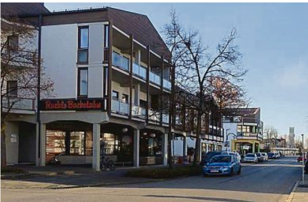
Wenig ansehnliches Straßenbild: So die Expertenmeinung zur Lochhauser Straße.
