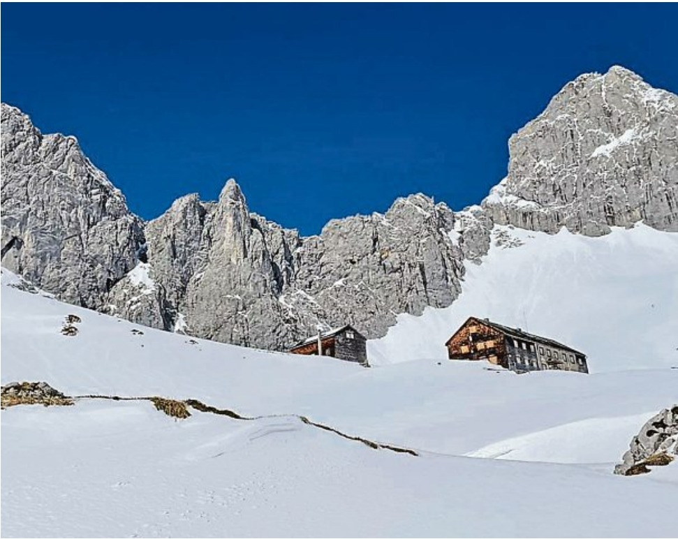
Rund um die Lamsenjochhütte herrscht bereits tiefster Winter. Im Gegensatz zu manchen anderen Hütten ist diese bereits geschlossen.
