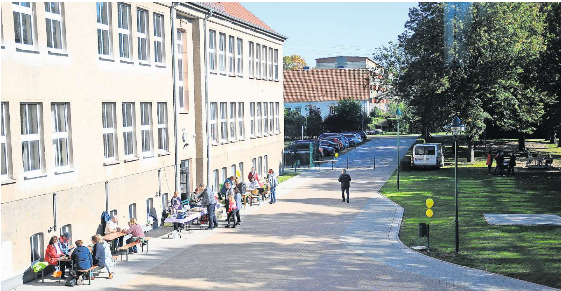
Der Schulhof in Berge ist bereits dank EU-Fördermittel neu gestaltet worden. Jetzt sollen die Räume im Untergeschoss des Gebäudes folgen.
