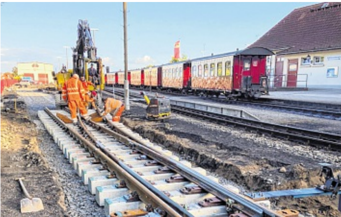
Am Bahnhof in Bad Doberan werden derzeit alte Weichen ausgetauscht, um die Eisenbahnsicherheit auch künftig gewährleisten zu können. Foto: MBB Molli GmbH
