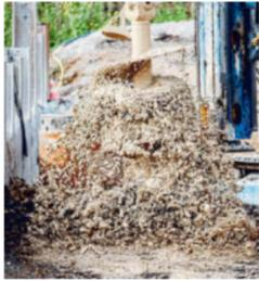
■ **Paderborn.** Schon von Weitem ist die mächtige Bohrvorrichtung zu sehen. 16 Meter tief frisst sich das Werkzeug des Riesenbohrers ins Erdreich. Einen Durchmesser von 1,20 Meter haben die entstehenden Löcher für insgesamt 20 mächtige Bohrpfähle. Diese bilden die Basis für ein Bauwerk, das im Vorfeld für große Diskussionen gesorgt hat.
