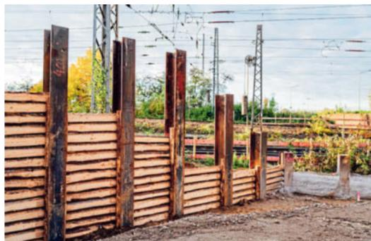
Diese Stahlträger mit einer Verlattung beziehungsweise Bewehrung aus Stahl und Spritzbeton sorgen für eine Standsicherung der Gleise.
