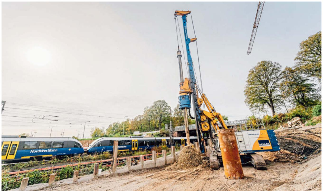
Neben den Gleisen, auf denen gerade die Nordwest-Bahn fährt, entsteht mit einem Spezialbohrgerät das erste Loch für die Pfahlgründung und das Fundament der neuen Brücke. Die alte Brücke wird später abgerissen.
