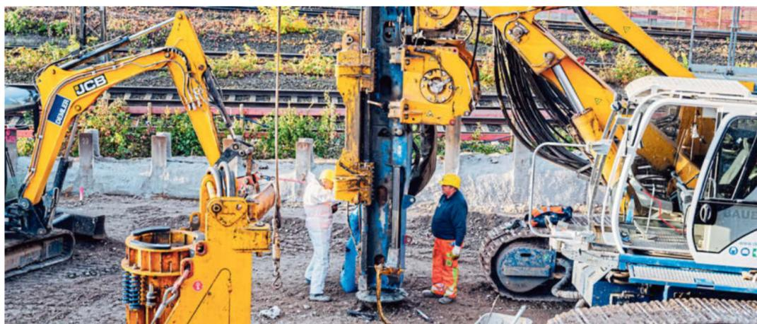
Dieses Foto zeigt das schwere Bohrgerät vor dem Einsatz, wie es von Mitarbeitern der Firma Demler überprüft und gewartet wird. Die Bohrentechnik läuft hydraulisch.
