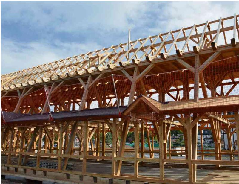
An der Westwand werden gerade die Vordächer gebaut.
