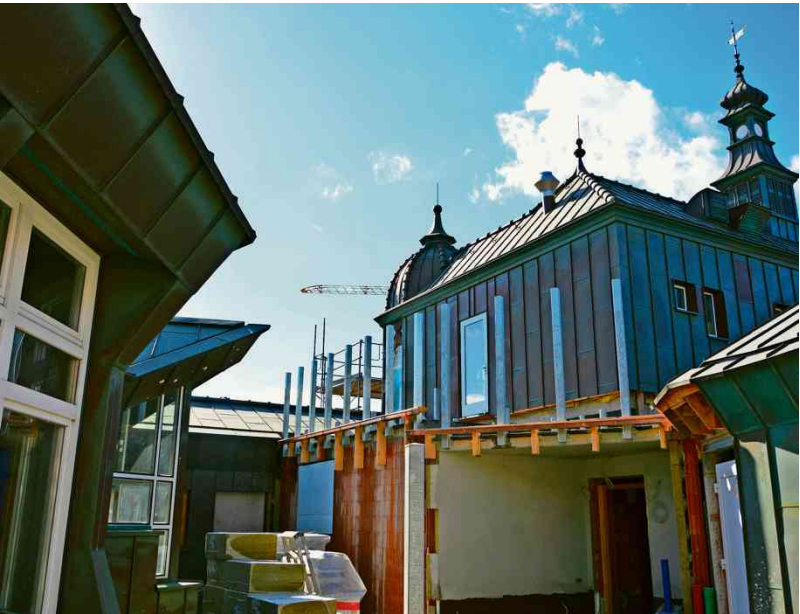
Am östlichen Teil des Mittelbaus wird ein weiterer Anbau platziert.
