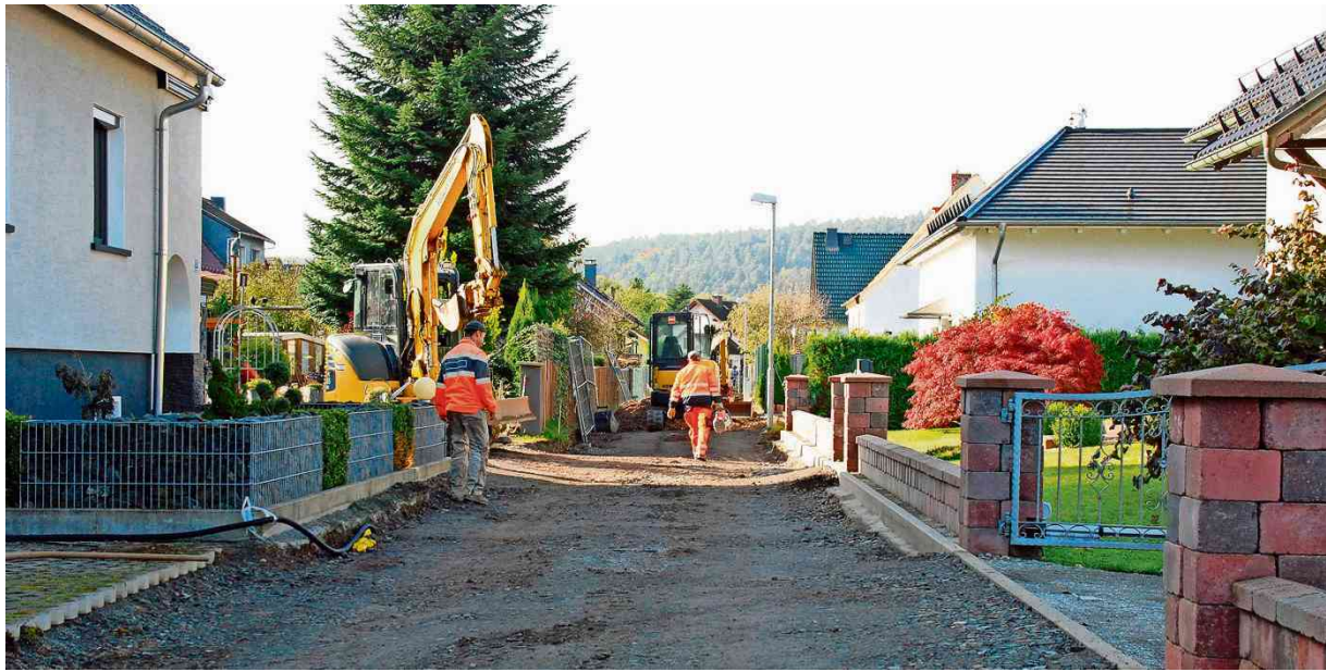
Der Ausbau des Werrawegs in Schwallungen hat begonnen. Hier werden neue Trinkwasserleitungen, ein Mischwasserkanal und erstmals eine Gasleitung verlegt.
