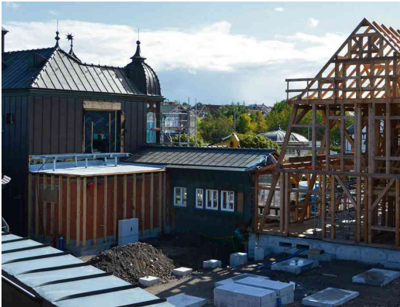
Der Sanitär-Anbau am westlichen Teil des Mittelbaus steht als Rohbau.
