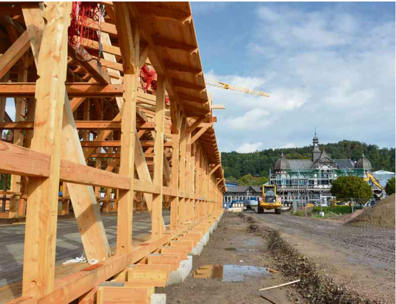
Auf der Gartenseite entstehen Vorrichtungen für Blumentröge.
