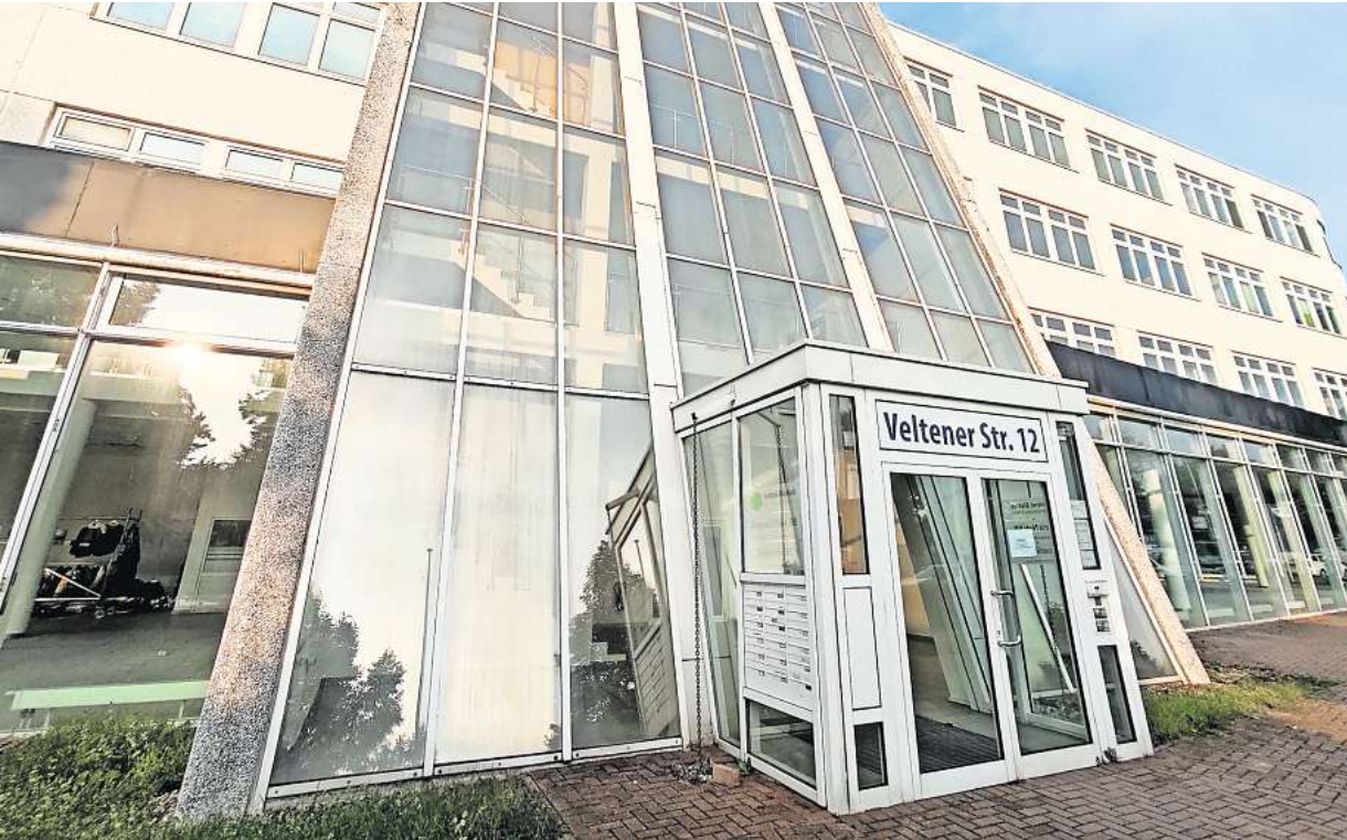
Das Haus in der Veltener Straße 12, Baujahr 1997, wird derzeit aufwendig saniert. Im Erdgeschoss wird es eine Art gläsernes Labor geben. FOTOS: MARCO PAETZEL, INVENT DIAGNOSTICA
