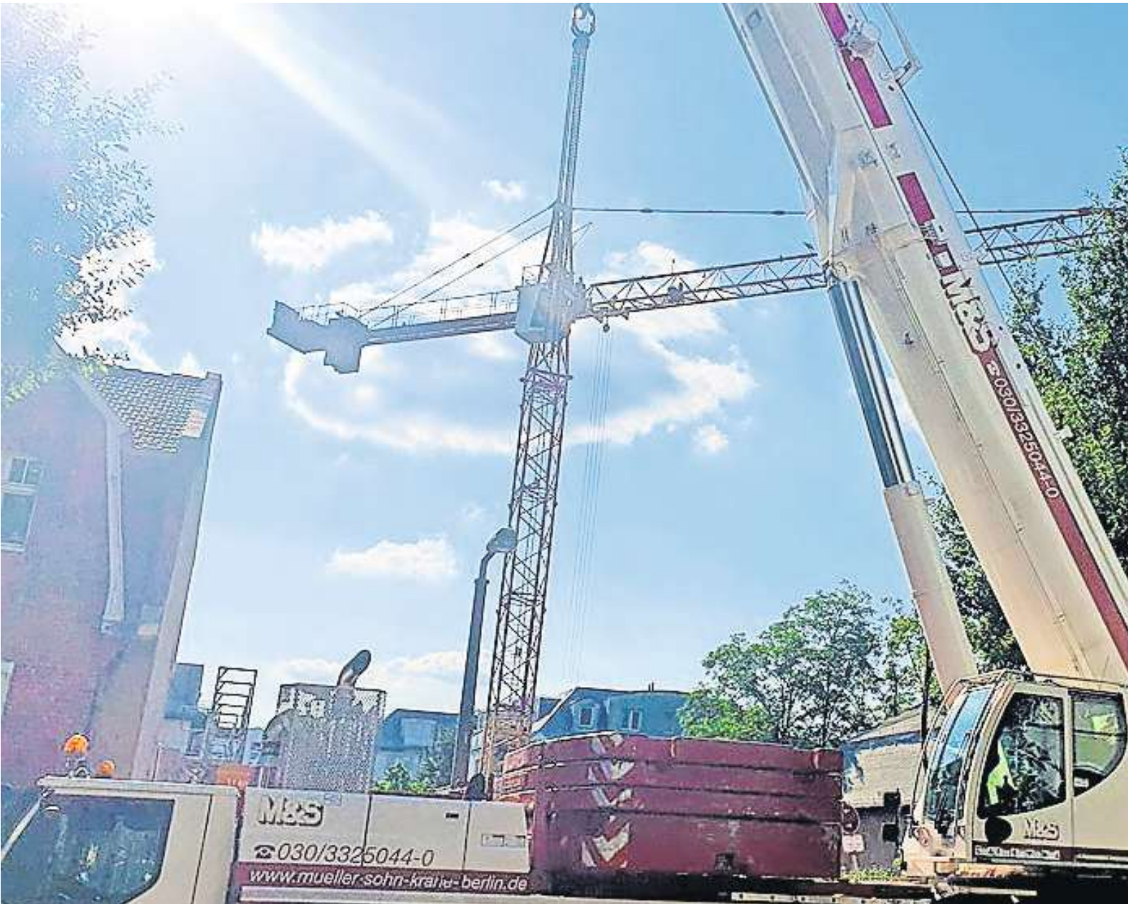
Eine Baufirma aus Birkenwerder musste ihren Turmdrehkran abbauen – weil sich der Nachbar von Vogelkot gestört fühlte.
