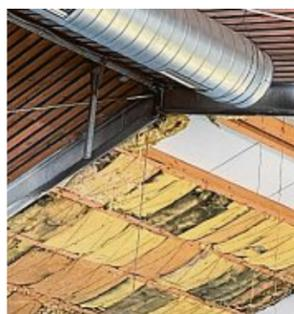
Die Spuren des Brands sind am Stahlträger noch sichtbar.
