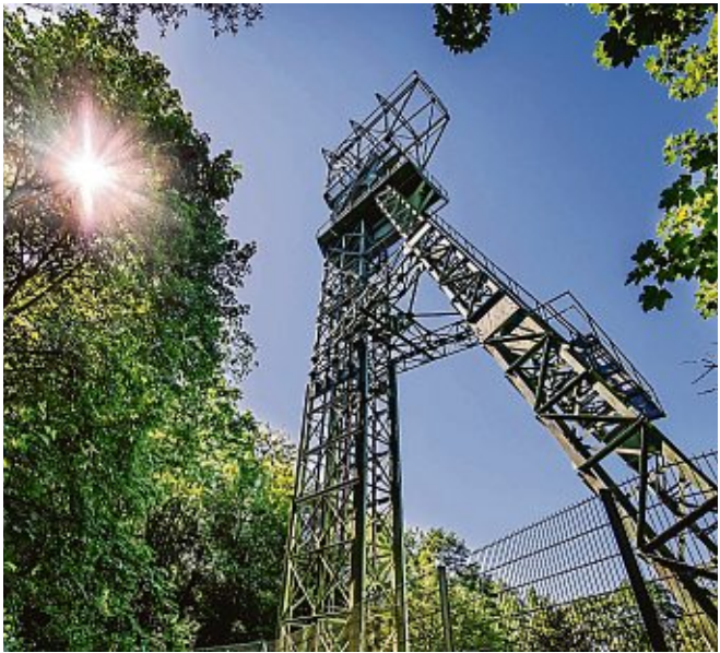
Der alte Förderer ist ein Industriedenkmal der ehemaligen Zeche Carl Funke am Baldeneysee.
