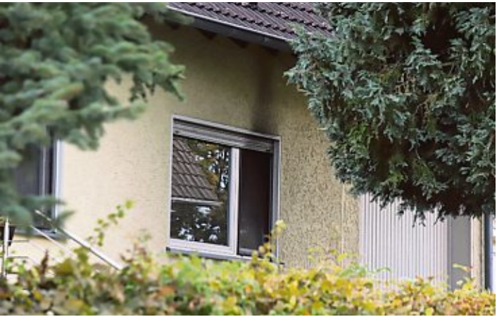
Der Brand blieb auf das Zimmer beschränkt, in dem die bettlägerige Frau gelegen hatte. Eine Rußfahne weist auf die Hitzeentwicklung hin.
