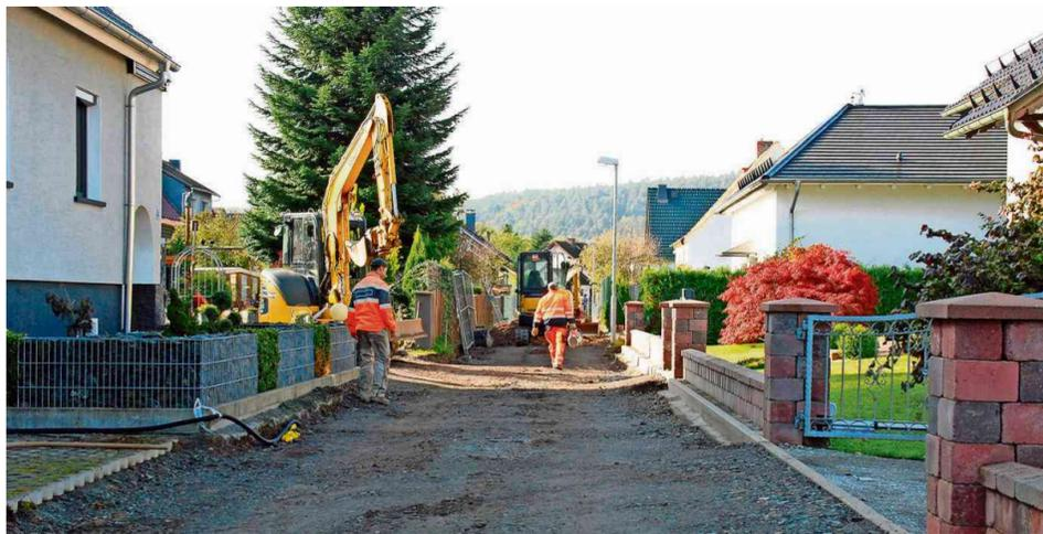
Der Ausbau des Werrawegs in Schwallungen hat begonnen. Hier werden neue Trinkwasserleitungen, ein Mischwasserkanal und erstmals eine Gasleitung verlegt.
