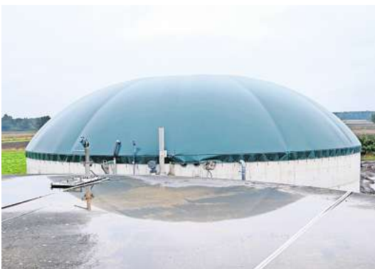
Unter der Kuppel der Biogasanlage wird das Gas gespeichert, das durch Gärung entstanden ist.
