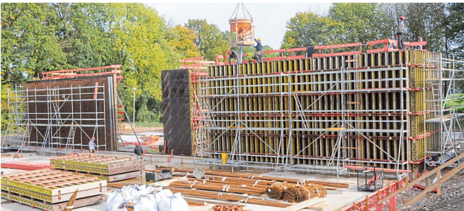
Die Betonmischer geben sich die Klinke in die Hand: Unter Hochdruck wird in diesen Tagen auf dem Kläranlagengelände an der Siegfriedstraße gearbeitet, um das gute Wetter auszunutzen. Unser Foto zeigt die Arbeiten an den zwei riesigen Betonbecken, in denen künftig die biologische Reinigung der Abwässer stattfinden wird.
