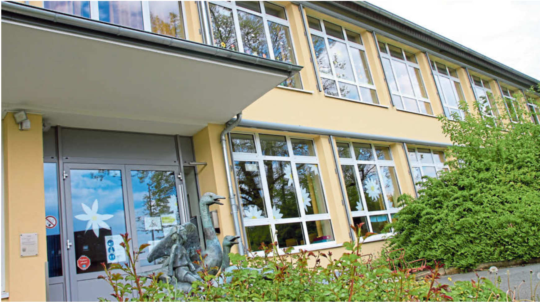
Steinheims städtische Schulen und Kindergärten erhalten im kommenden Jahr neue Lüftungsanlagen.
