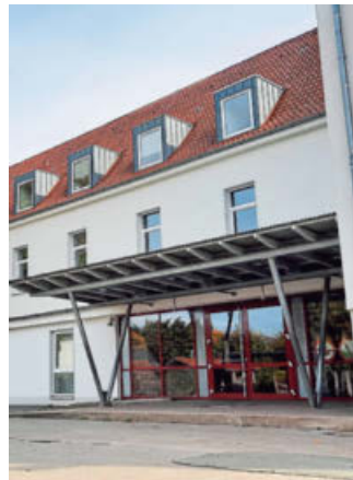
Der Umbau der Vinsebecker Grundschule an den Linden wird sich um Jahre verzögern.
