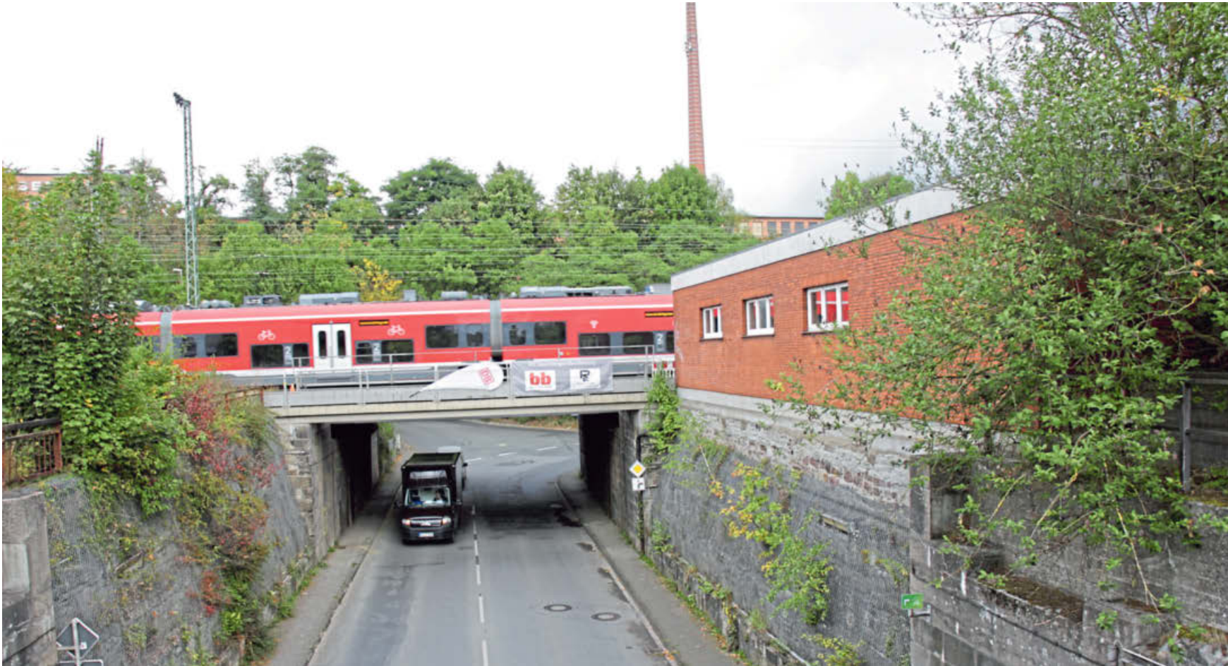
Heir wird es eng: Über der Desenbergstraße wird bis Sommer 2024 die Eisenbahnüberführung erneuert. Die Bauarbeiten beginnen mit dem Abriss des ehemaligen Werkstattgebäudes (r.).
