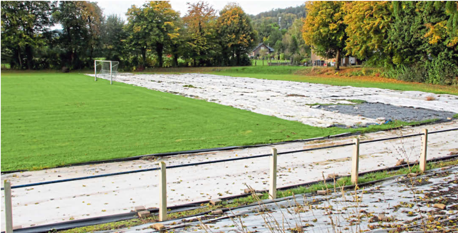
Im Randbereich des Fußballplatzes, wo ein Leichtathletik-Bereich entstehen soll, muss die Erde ausgetauscht werden, da dort Dioxin-Rückstände festgestellt worden waren.
