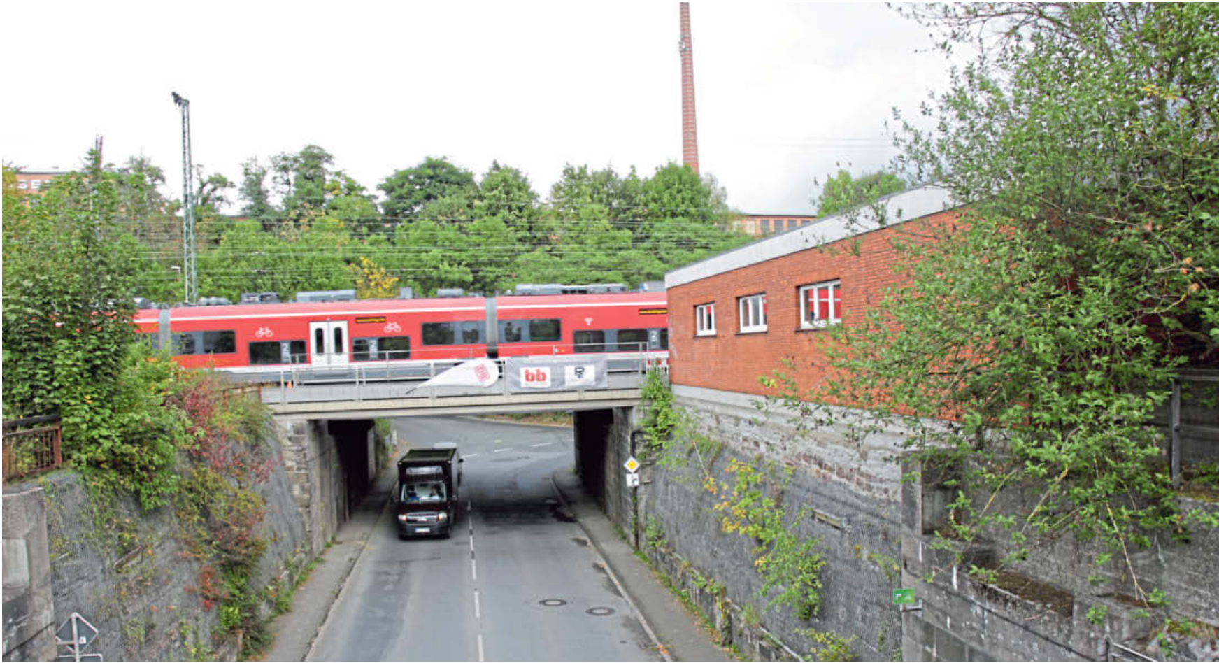
Heir wird es eng: Über der Desenbergstraße wird bis Sommer 2024 die Eisenbahnüberführung erneuert. Die Bauarbeiten beginnen mit dem Abriss des ehemaligen Werkstattgebäudes (r.). Foto: Dieter Scholz
