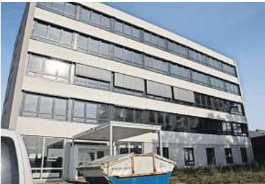
Das ehemalige Verwaltungsgebäude an der Industriestraße soll nun teilweise gewerblich genutzt werden.
