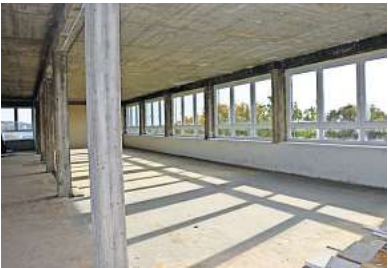
In die noch leeren Hallen im Erdgeschoss und ersten Obergeschoss wird die Firma Greten-Technik einziehen.
