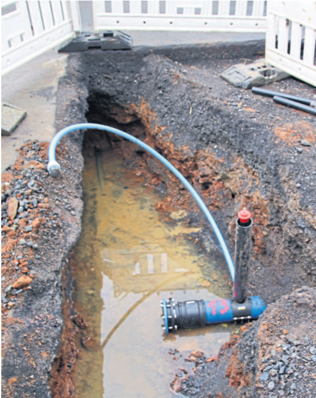
Beim Ausbau der Ohmstraße in der Kernstadt Ulrichstein wird auch die Wasserversorgung saniert. Diese Kosten werden wohl über Gebühren bezahlt.
