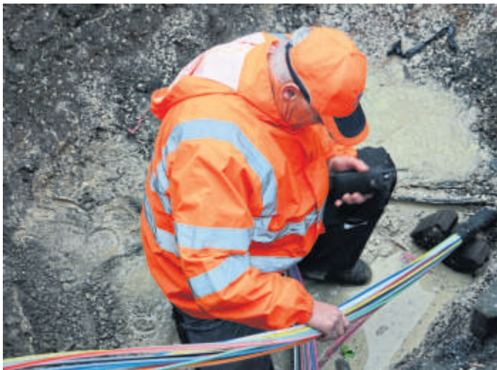
Ein Bauarbeiter zieht in einem Bauschacht ein Breitbandkabel aus einem Leerrohr.
