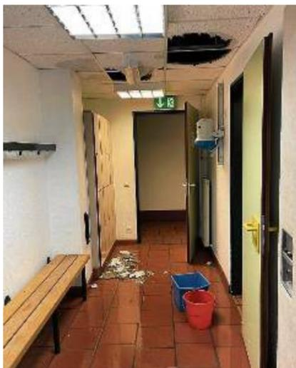
Wasser tropft durch die Decke in den Flur, der zu den Umkleideräumen führt. Platten sind zu Boden gestürzt. FOTO: UBE
