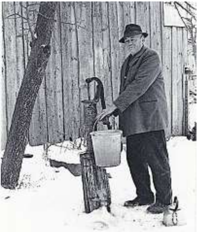
Ein Pumpenstock war schon etwas fortschrittlicher. Xavier Fruchtl hatte so eine Pumpe bis in die 1960er-Jahre.
