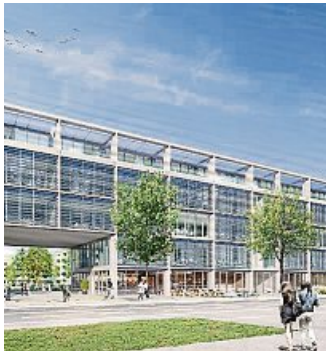
Das Projekt soll 2023 fertig sein.
