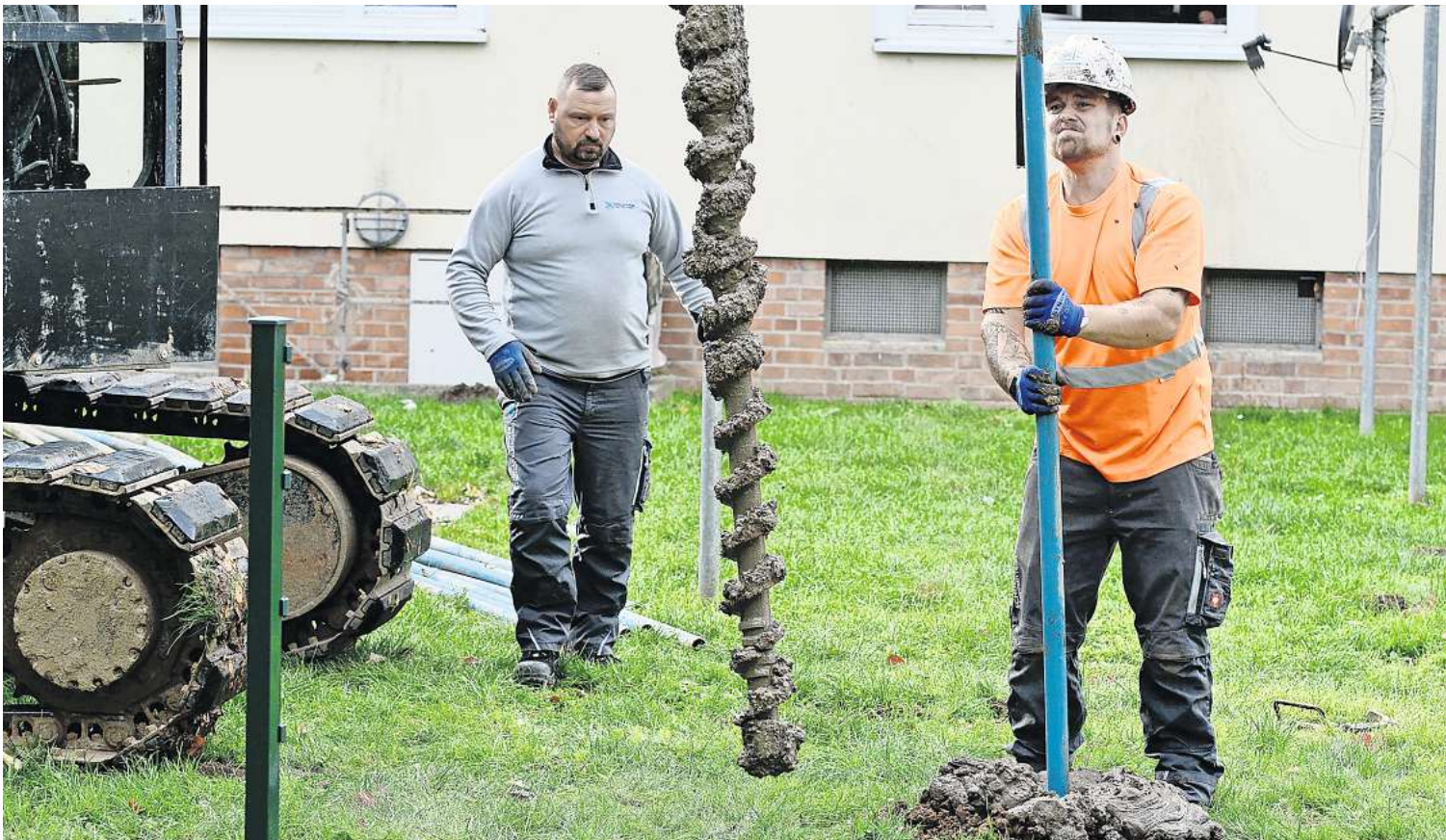
Die Sondierungsarbeiten mithilfe von Magnetsonden für die 80 Verdachtspunkte entlang der westlichen Leineseite haben begonnen. Dieser Sondierungspunkt auf dem Wäscheplatz eines Innenhofes soll kommenden Mittwoch untersucht werden. Durch den Hof führt eine Gasleitung, sie muss abgeklemmt werden.
