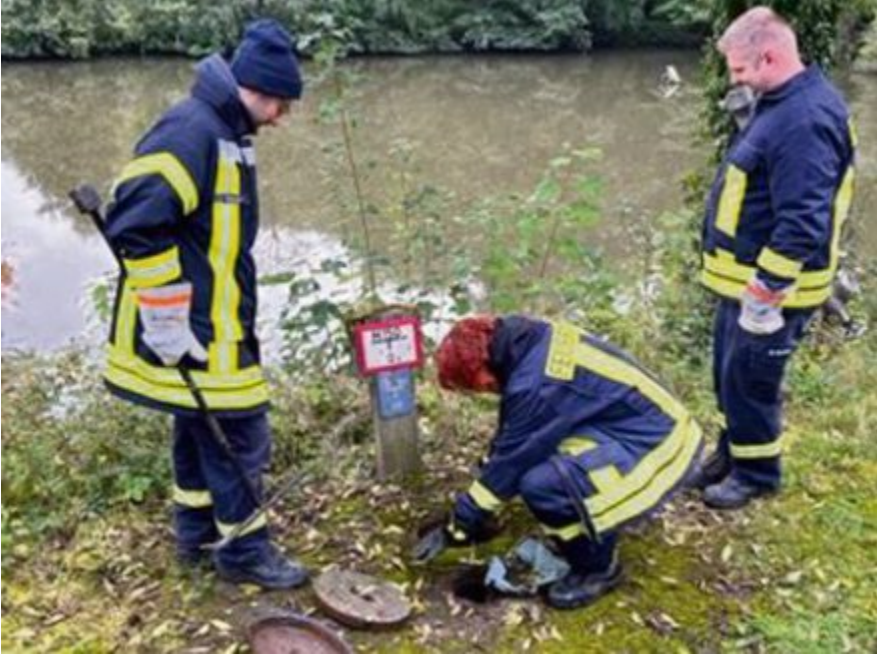
Bei der Überprüfung dieses Hydranten ist die Eigensicherung der Brandschützer im Gegenzug zu den Kontrollen auf dem „Auetal-Highway“ kein Thema.
