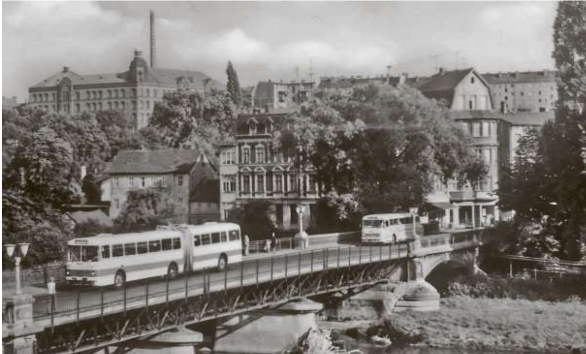
Die Karl-Marx-Brücke, heute Auebrücke, ist mit zwei typischen Bussen zu DDR-Zeiten zu sehen.
