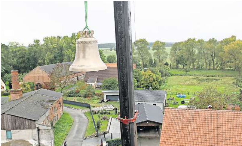
Die neue Glocke für den Demerthiner Kirchturm schwebt ein.
