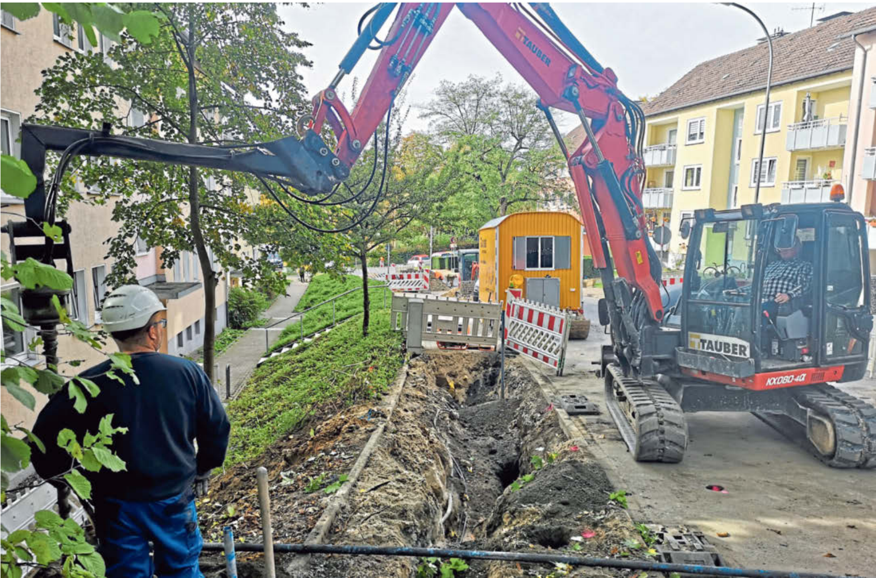
Mit einem speziellen Bohrer am Baggerarm gelangen die Experten in die Tiefe. Sie nutzen dann eine Sonde, um für Klarheit zu sorgen und die Frage zu klären, ob es sich um eine Bombe handelt.
