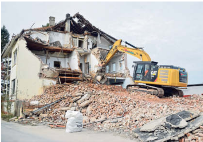
Das Gebäude an der Bahnhofstraße/Ecke Brüderstraße wird abgerissen. Foto: Mareike Patock
