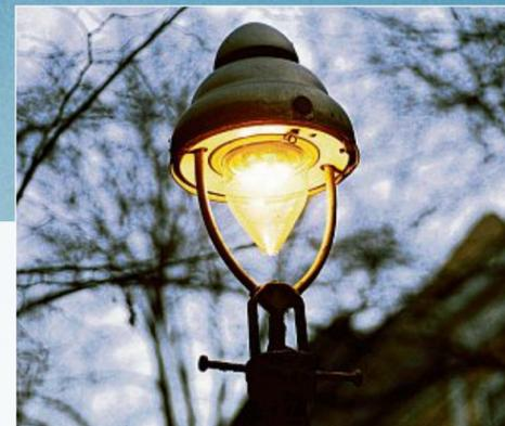
Die Aufsatzleuchte, der am weitesten verbreitete Typ, kam in den 20er-Jahren auf. Die heute verwendete Form Bamag U7 wird seit den 1950ern eingesetzt.
