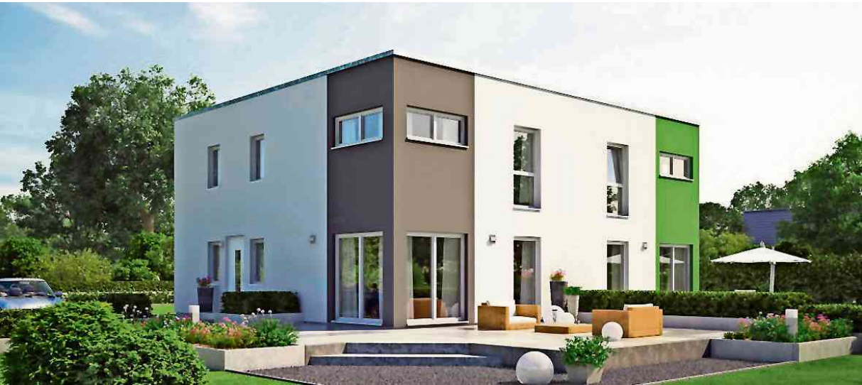
Die Fassadengestaltung sollte zum Architekturstil eines Hauses passen.
