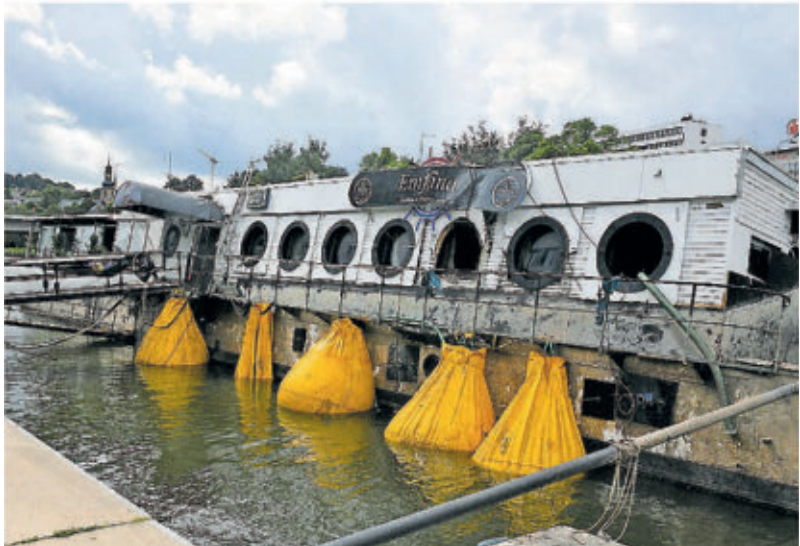
Die gelben Luftsäcke ermöglichen jeweils Auftrieb für fünf Tonnen Gewicht. Damit wurde das erneute Umkippen des Pontons verhindert.
