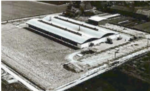
Die Fabrik an der Bündler Straße, später folgten Bau-Erweiterungen.
