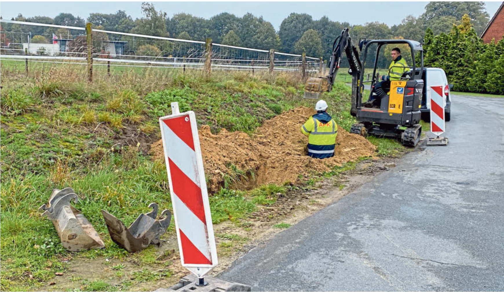
Für Anwohner am Römerweg bleibt das Verlegen der Glasfaserkabel in ihre Häuser rätselhaft. Die Westnetz GmbH sieht hier keine Probleme.
