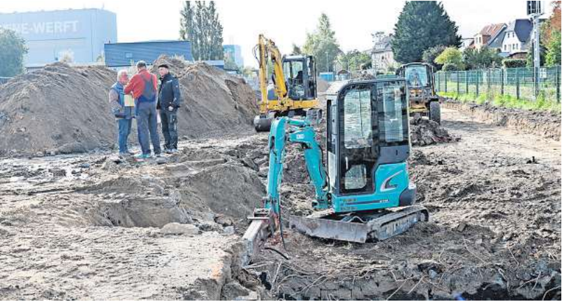
In Wolgast wird die Straße Am Speicher saniert.
