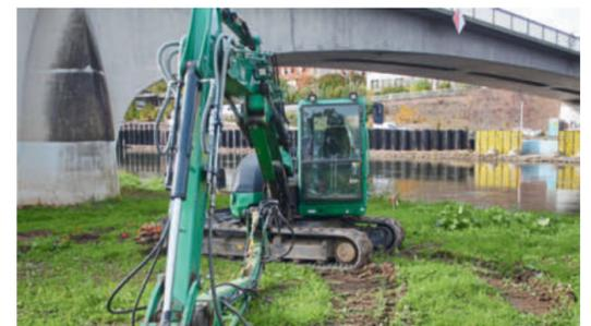
Mit diesem grünen Bagger und Bohrgerät wird seit Montag unterhalb der Weserbrücke nach möglichen Kampfmitteln aus dem zweiten Weltkrieg gesucht. Foto: Jürgen Drüke
