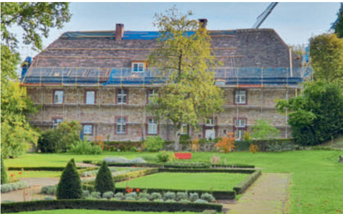
Diese Seite des Daches von Haus Nummer 10 konnte komplett mit dem bisherigen Bestand des Solling-Sandsteins neu gedeckt werden. Ein kleiner Teil (rechts) musste erst gar nicht abgenommen werden.
