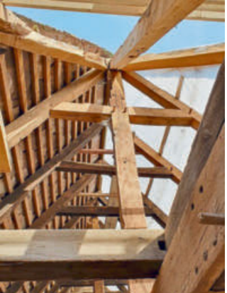
Die Holzkonstruktion muss einiges tragen können – das Dach ist extrem schwer.
