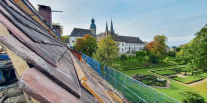
Solling-Sandstein wird immer in Doppeldeckung gelegt. Im Hintergrund: die Abteitürme und der Klostergarten.
