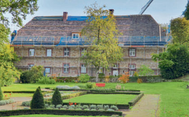
Diese Seite des Daches von Haus Nummer 10 konnte komplett mit dem bisherigen Bestand des Solling-Sandsteins neu gedeckt werden. Ein kleiner Teil (rechts) musste erst gar nicht abgenommen werden.
